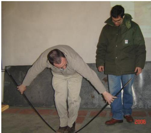
Foto 12: Posición del cuerpo para realizar el doblado del hierro
